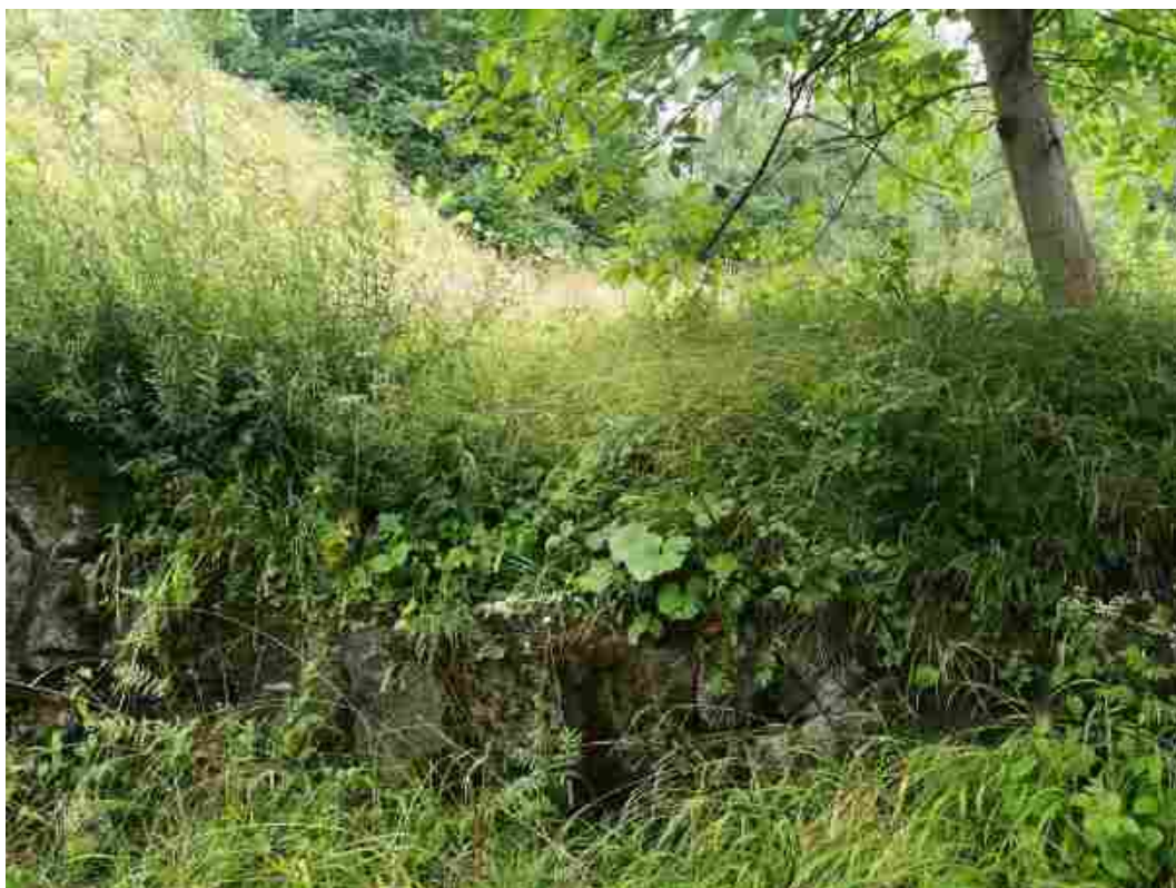
FOTOGRAFIA 2 WIDOK NA PRZELEW OD STRONY WODY DOLNEJ.
