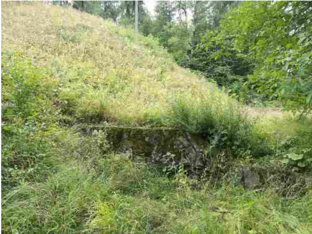
FOTOGRAFIA 3 WIDOK NA PRAWE SKRZYDŁO OD STRONY WODY DOLNEJ.
