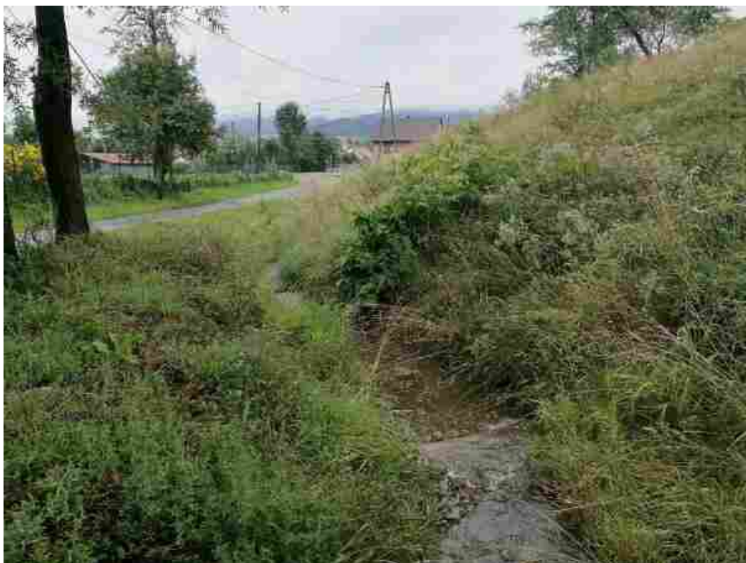
FOTOGRAFIA 6 WIDOK NA STANOWISKO DOLNE ZAPORY.
